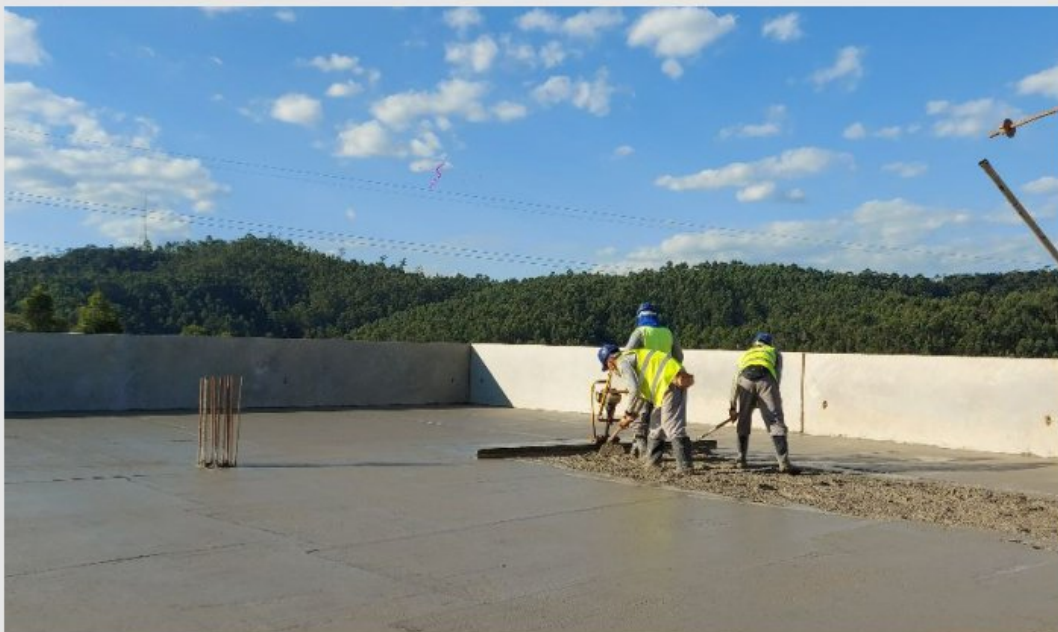
Figura 3 - Execução de capa após preenchimento das vigas, chavetas e alvéolos
